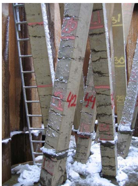
Figur 2.13. Typiska skador på betongpålar orsakade av vattensprängning.
